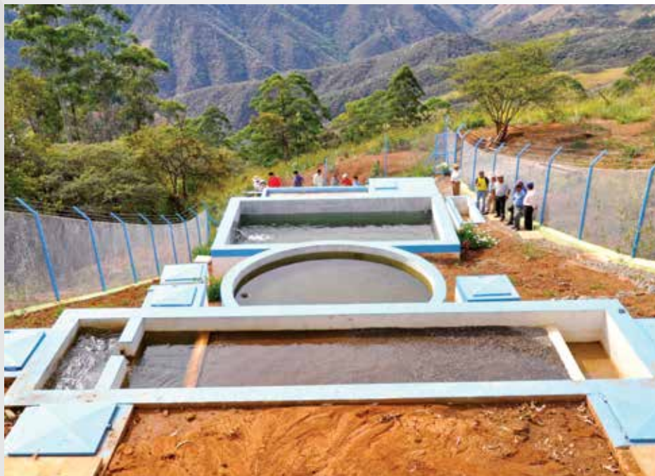
Planta de tratamiento de agua. Foto Senplades
