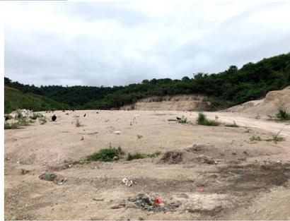
Foto 26: Sitio de operación totalmente cubiertos los residuos
