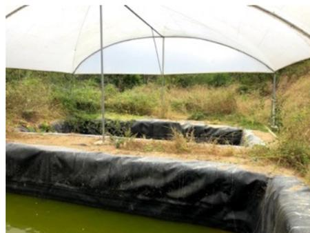
Foto 13: Fosas para recepción de lixiviados, con agua pluvial.
