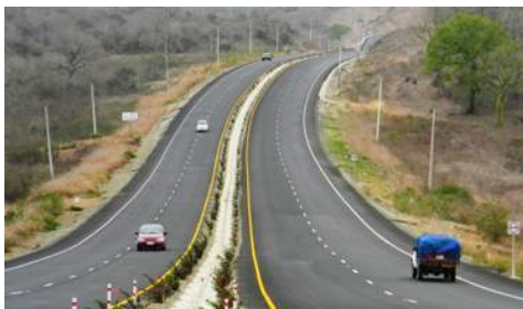
Fotografía No. 3 Infraestructura vial en Manabí 2012
