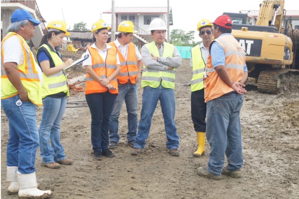
Foto N° 12 Seguimiento y Evaluación al proyecto habitacional “La Tablada de Sánchez”
