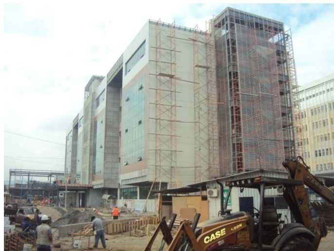
Ilustración 302. Hospital Abel Gilbert Pontón FUENTE: Dirección de Inversiones, Seguimiento y Evaluación Z8-2014
