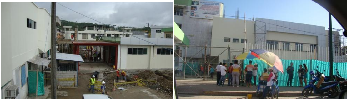
Bloque de construcción de cocina y consulta externa
